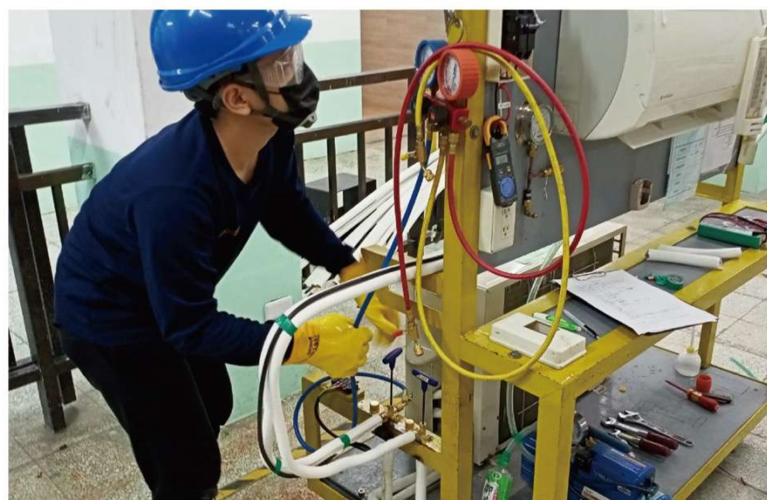
圖1 分離式冷氣冷媒系統處理
